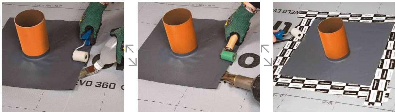
ROLLER, WELD LIQUID, CUTTER, HOT GUN
